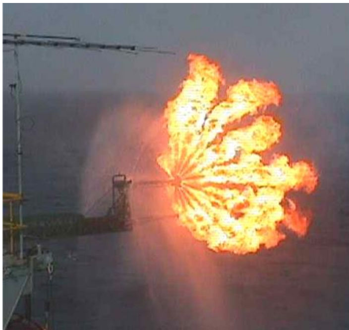
Рисунок 5.1 – Водяной защитный экран факельной горелки
