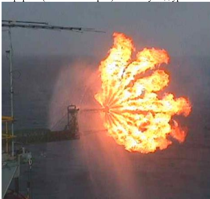
Рисунок 5.1 – Водяной защитный экран факельной горелки
