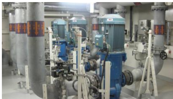
Рисунок 7.8 – Система охлаждения вспомогательных механизмов
