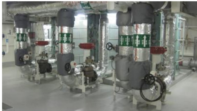
Рисунок 7.7 – Система охлаждения тосола забортной морской водой
