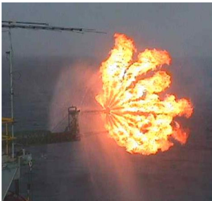
Рисунок 5.1 – Водяной защитный экран факельной горелки
