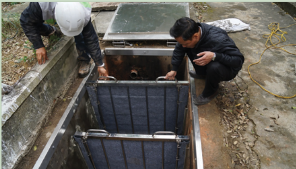
Рис. 6. Сменные кассеты на основе материала SoS (Вьетнам) в нефтеотстойниках
